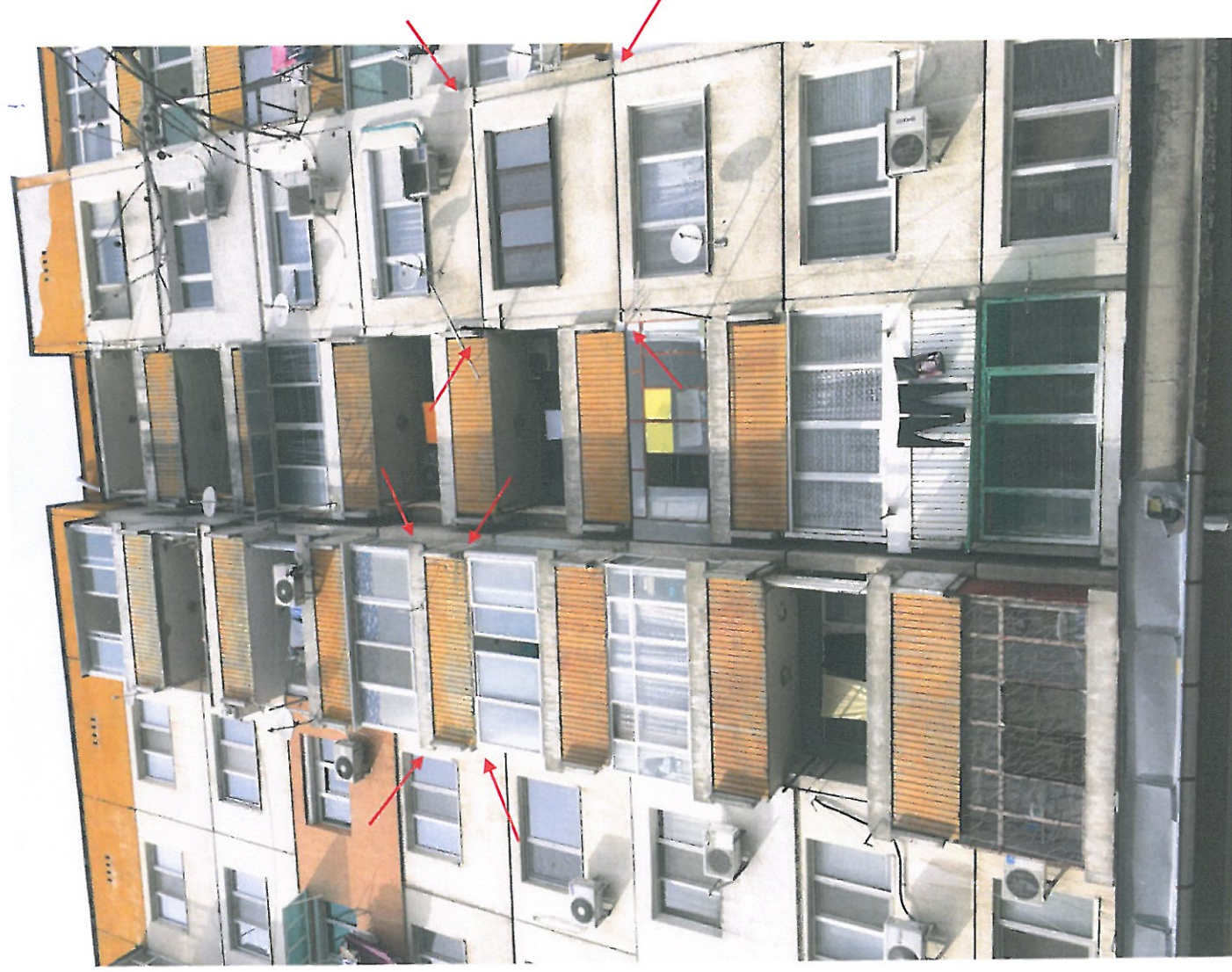
Фиг.43 ( —→ ) Точки на закрепване на различните видове панели
