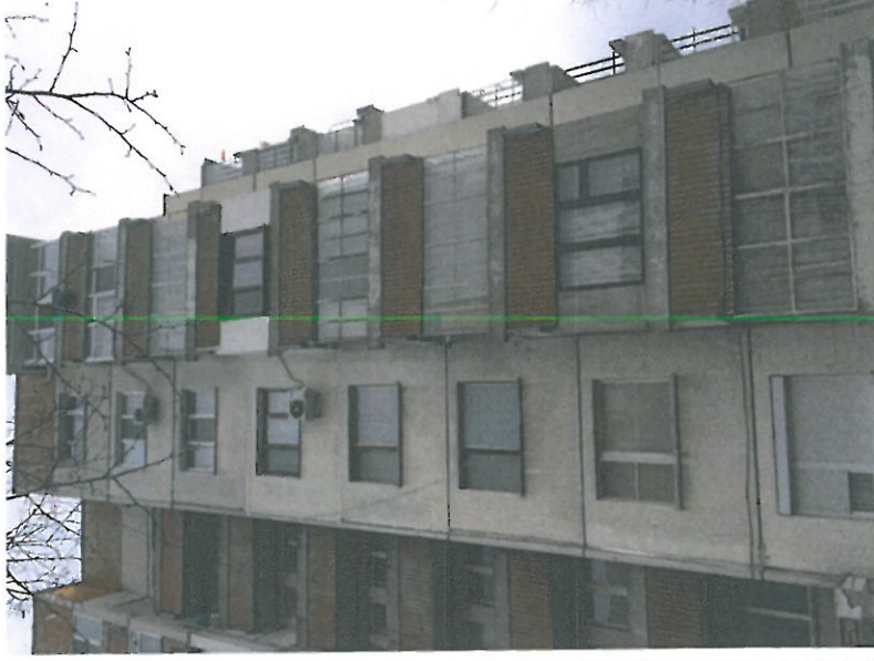
Фиг.15,16,17,18,19,20,21,22,23,24,25,26 Северна фасада (Усвояване на лоджий, остъкляване на тераси, дозидане на прозорци, частично полагане на топлоизолация, частично разрушена мазилка по фасадата, компрометирана хидроизолация над входни козирки)
