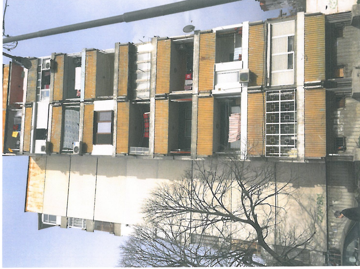
Фиг.27. Западна фасада (Усвояване на лоджии, остъкляване на тераси, дозиждане на прозорци, частично разрушена мазилка по фасадага)
