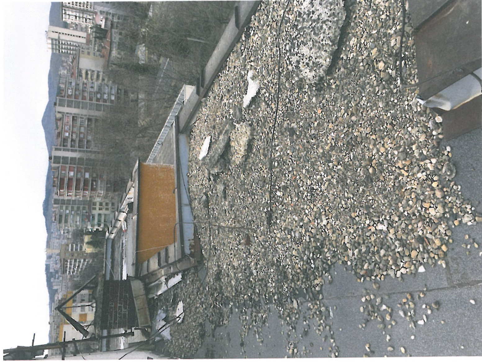
Фиг.7. Неефективен завършващ слой, затрудняващ водоотвеждането
