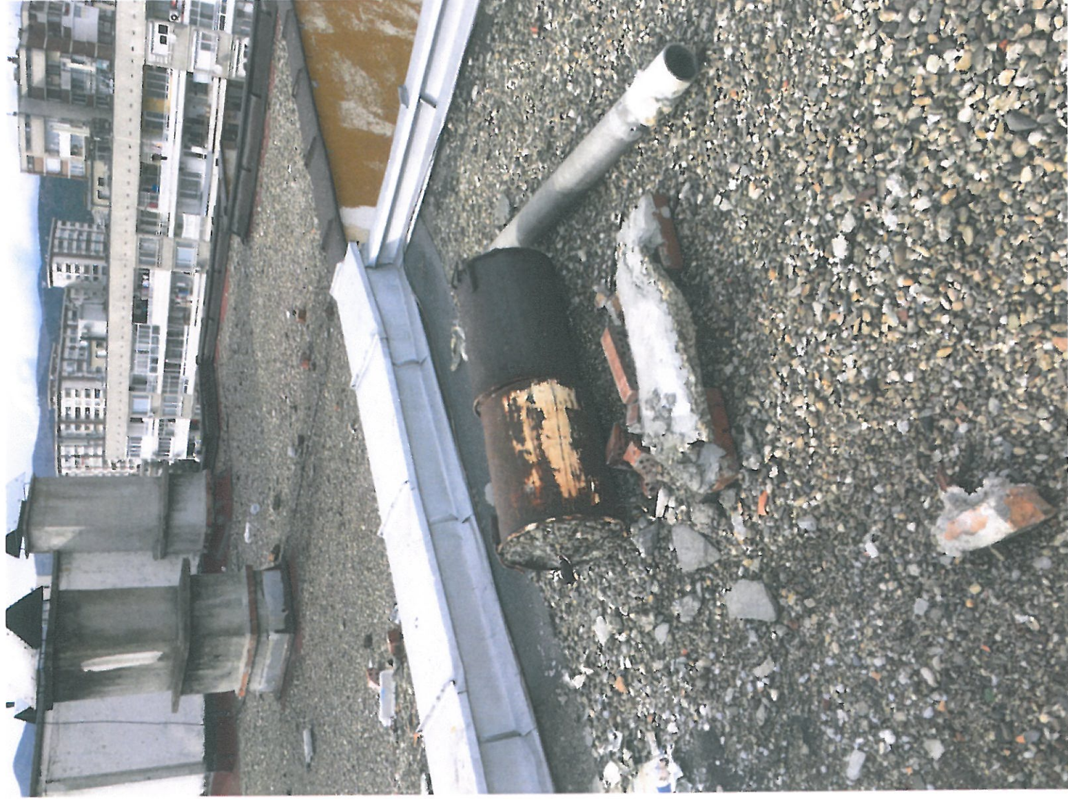
Фиг. 4,5,6. Неефективни ламаринен борд, воронки и вентилационни гръби
