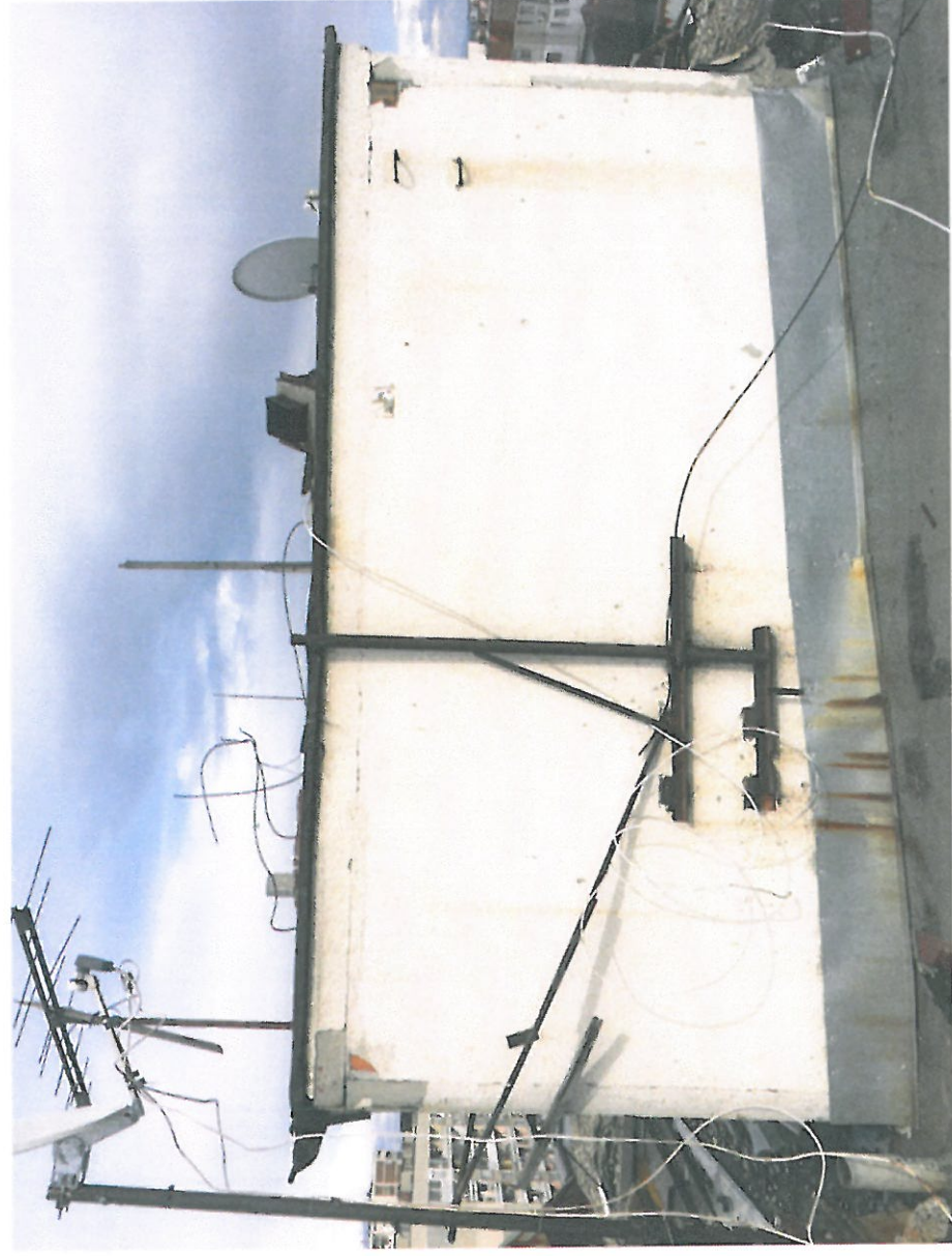
Фиг.10,11. Стара неефективна или липсваща мълниезащита
