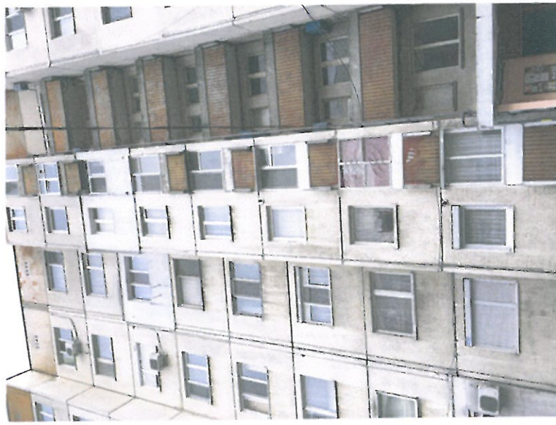
Фиг.15,16,17,18,19,20,21,22,23,24,25,26 Северна фасада (Усвояване на лоджий, остъкляване на тераси, дозидане на прозорци, частично полагане на топлоизолация, частично разрушена мазилка по фасадата, компрометирана хидроизолация над входни козирки)
