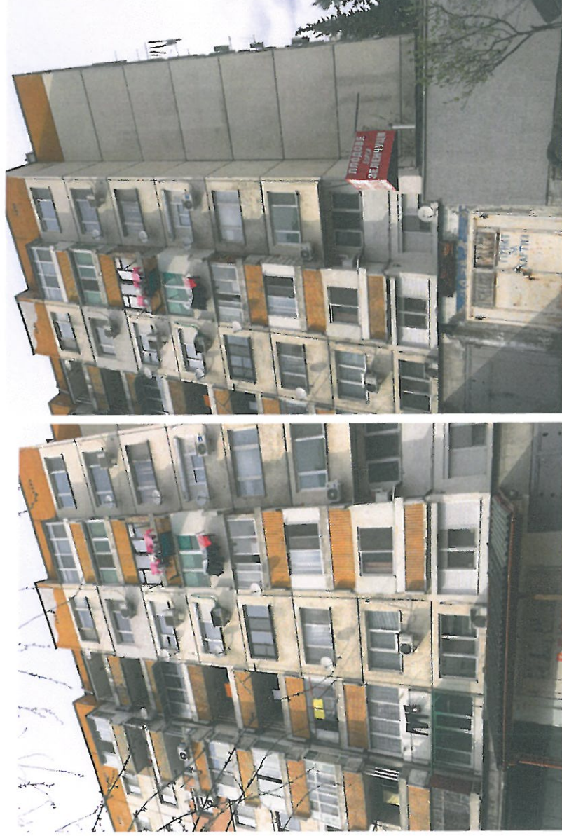
Фиг.29,30,31,32,33,34,35,36,37,38,39,40,41,42. Южна фасада (Усвояване на лоджии, остъкляване на тераси, дозигждане на прозорци, частично полагане на топлоизолация, частично разрушена мазилка по фасадата, компрометирана хидроизолация над входни козирки)
