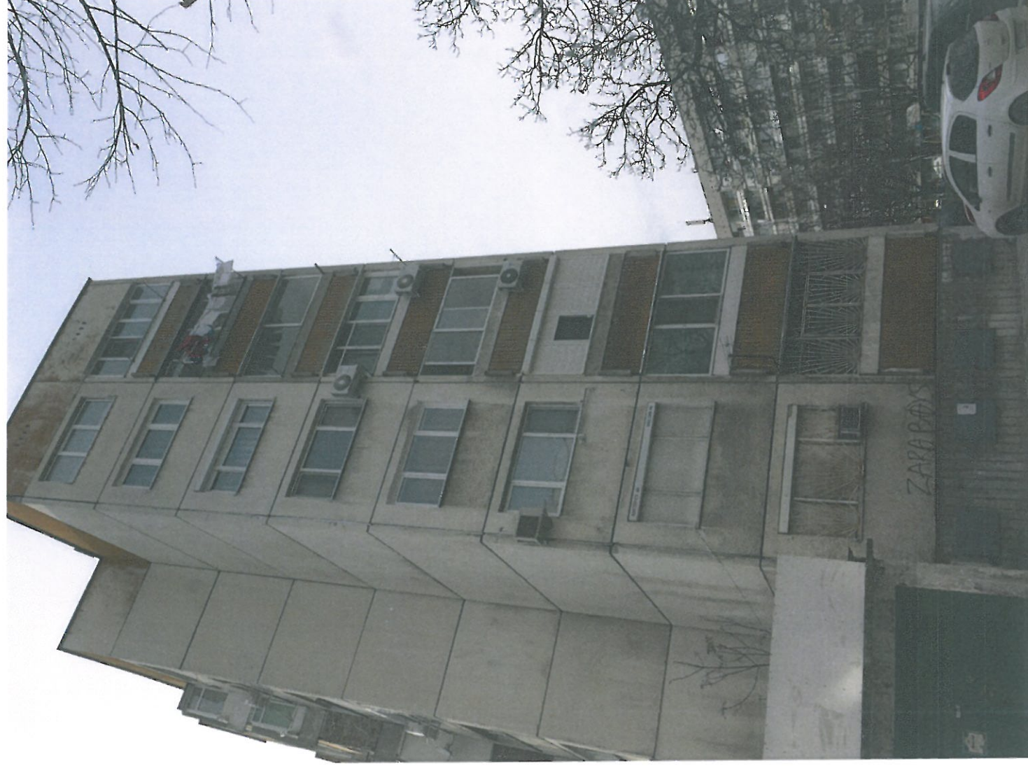
Фиг. 28. Източна фасада (Усвояване на лоджии, остъкляване на тераси, дозиждане на прозорци, частично разрушена мазилка по фасадата)
