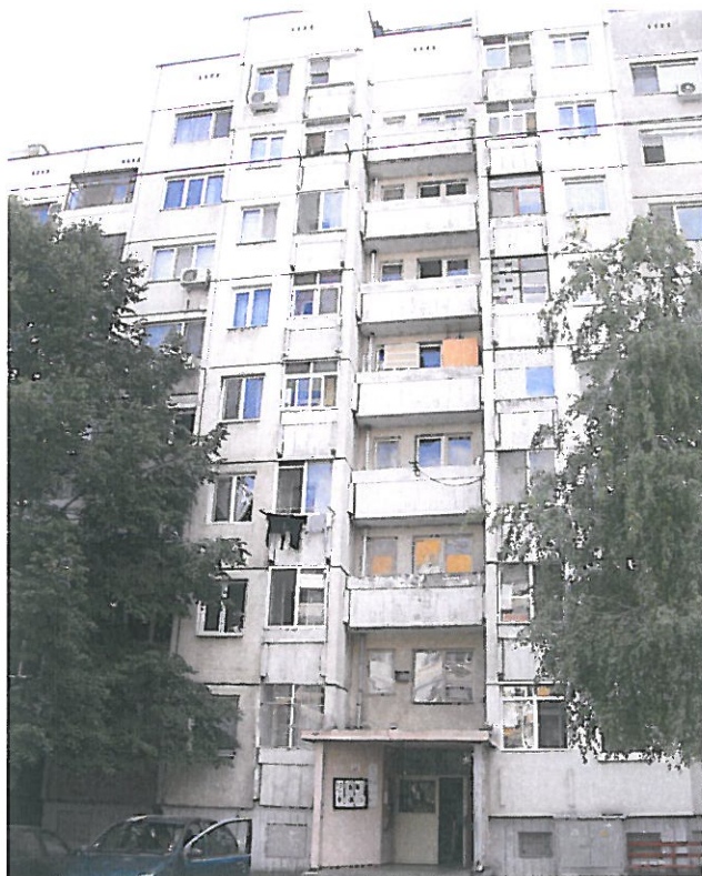
Фиг.12,13,14,15 Северна фасада (Усвояване на лоджии, остъкляване на тераси, дозиждане на прозорци, частично полагане на топлоизолация, частично разрушена мазилка по фасадата, компрометирана хидроизолация над входни козирки)
