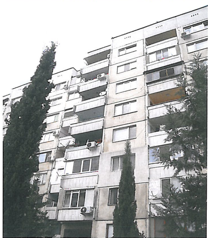
Фиг.16,17,18,19 Южна фасада (Усвояване на лоджии, остъкляване на тераси, дозиждане на прозорци, частично полагане на топлоизолация, частично разрушена мазилка по фасадата)
