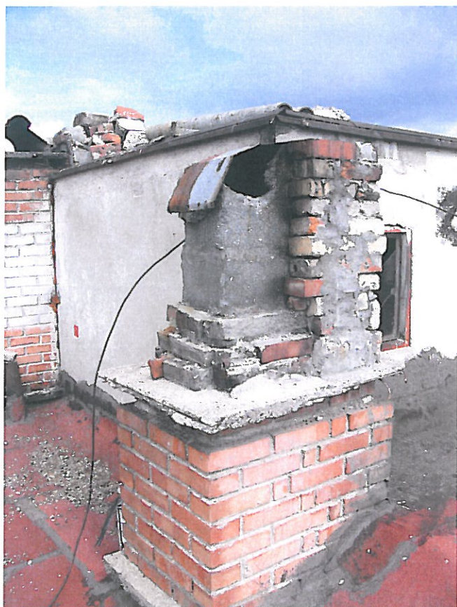
фиг. 3 Разрушени комини и липсващи шапки на комини
