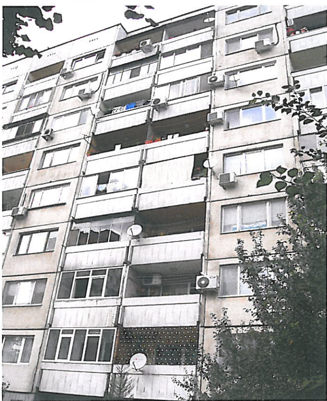
Фиг.16,17,18,19 Южна фасада (Усвояване на лоджии, остъкляване на тераси, дозиждане на прозорци, частично полагане на топлоизолация, частично разрушена мазилка по фасадата)
