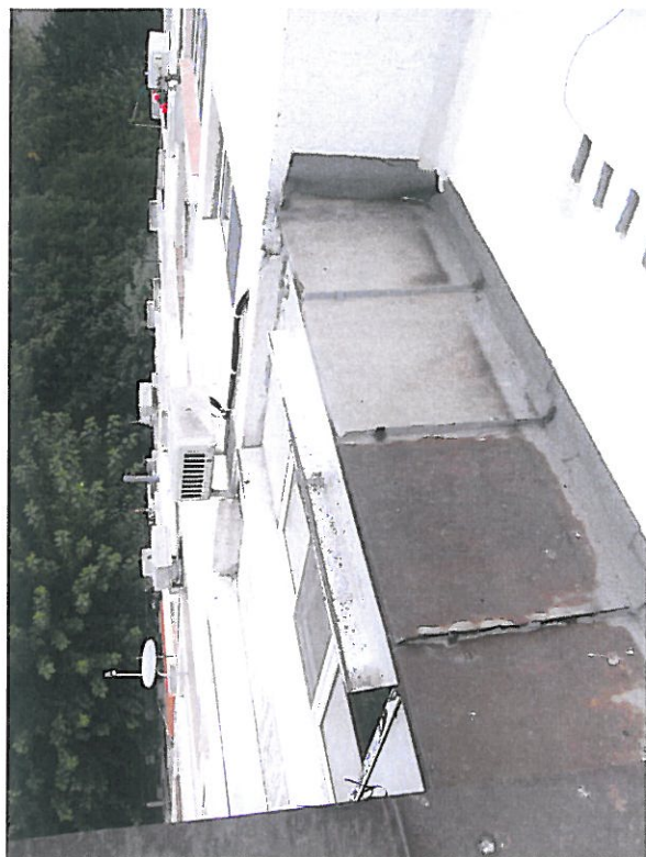
Фиг. 7 Ръждясала и неефективна обшивка на покрив
