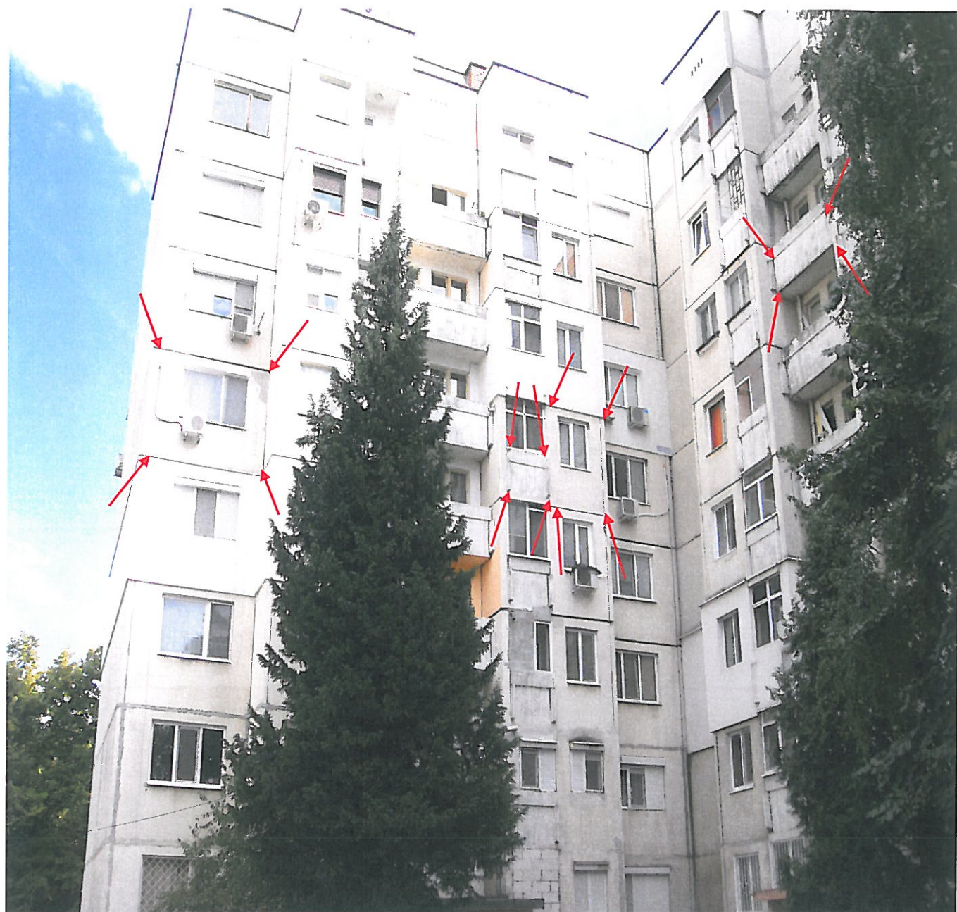
Фиг.22 ( —→ ) Точки на закрепване на различните видове панели.
