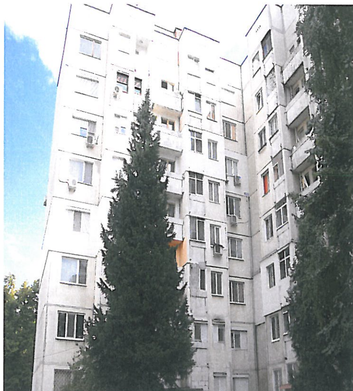
Фиг.12,13,14,15 Северна фасада (Усвояване на лоджии, остъкляване на тераси, дозиждане на прозорци, частично полагане на топлоизолация, частично разрушена мазилка по фасадата, компрометирана хидроизолация над входни козирки)
