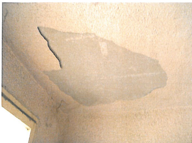
фиг. 1 Компрометирана мазилка в общи части
