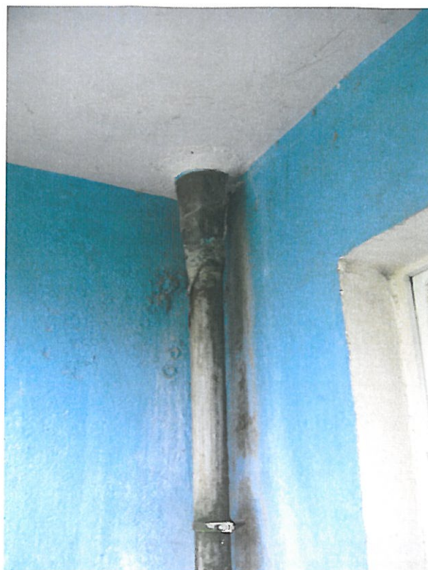
фиг.6 Изгнила водосточна тръба
