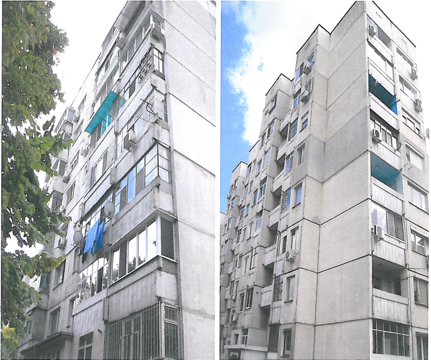
Фиг.20,21 Източна и западна фасада (Усвояване на лоджии, остъкляване на тераси, дозиждане на прозорци, частично полагане на топлоизолация, частично разрушена мазилка по фасадата)
